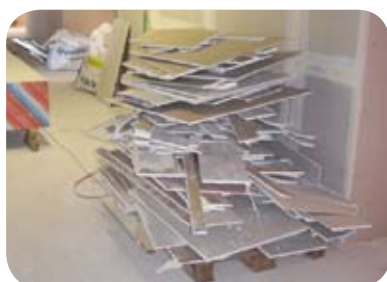
Ejemplos del uso inadecuado de sistemas de acopio en el tajo
