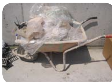
Ejemplos del uso inadecuado de sistemas de acopio en el tajo
