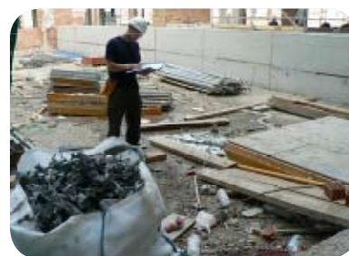
El TMA realizando un Control de Obra
