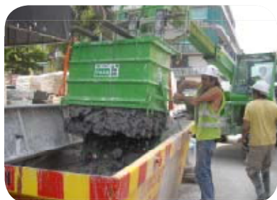
El barro del pulido hay que separarlo del escombros limpio
