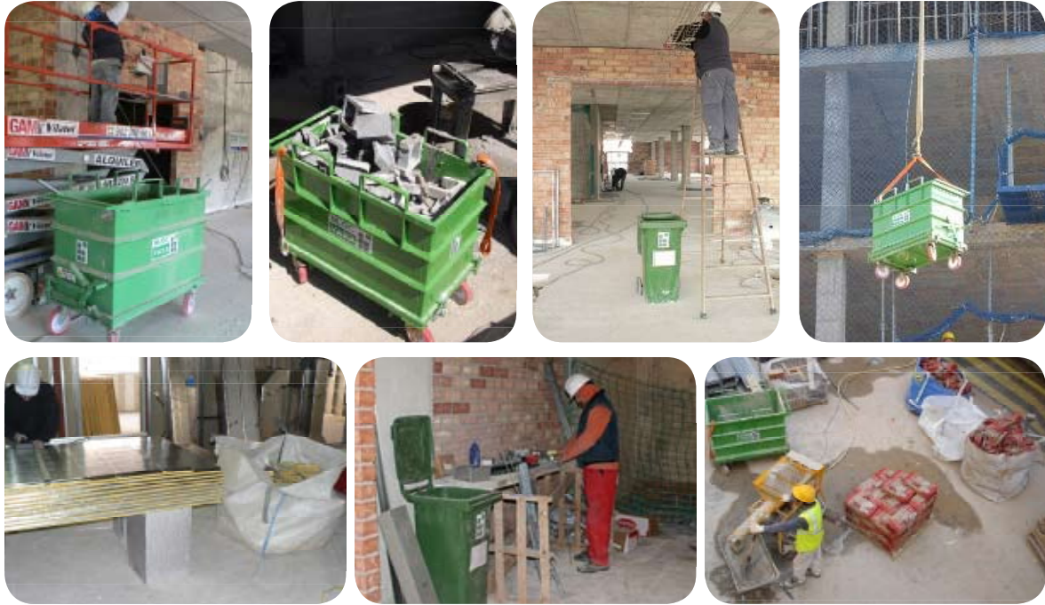
Ejemplos del uso adecuado de contenedores de tajo en plena faena
